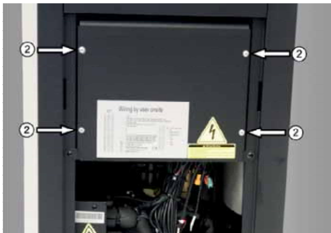
Bevestigingsschroeven (2) van de afdekking van de aansluitklemmen
